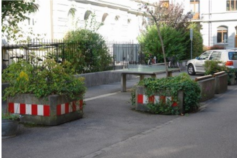
Abbildung 22: Heute nicht mehr standardgemässe Pflanztröge, Sitzbänke und Pingpong-tisch in einer ehemaligen Wohnstrasse, heute als Begegnungszone signalisiert.
